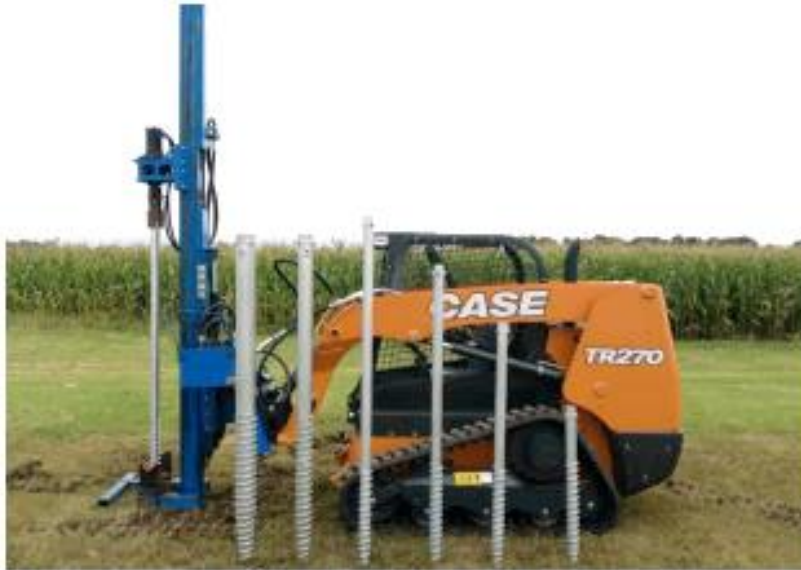
Slika 8. Prikaz stroja za zavijanje stupova u zemlju
