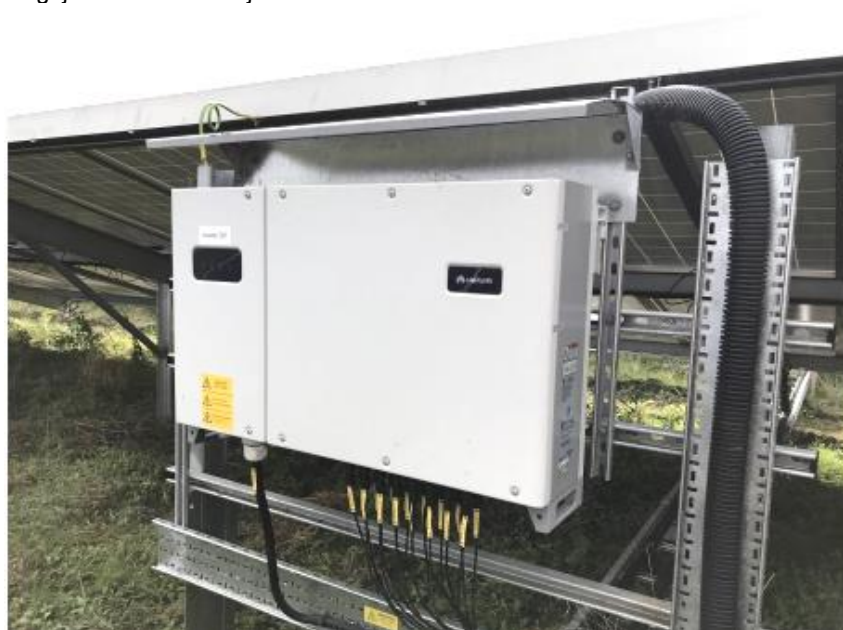
Slika 7. Detalj montaže izmjenjivača na konstrukciju
