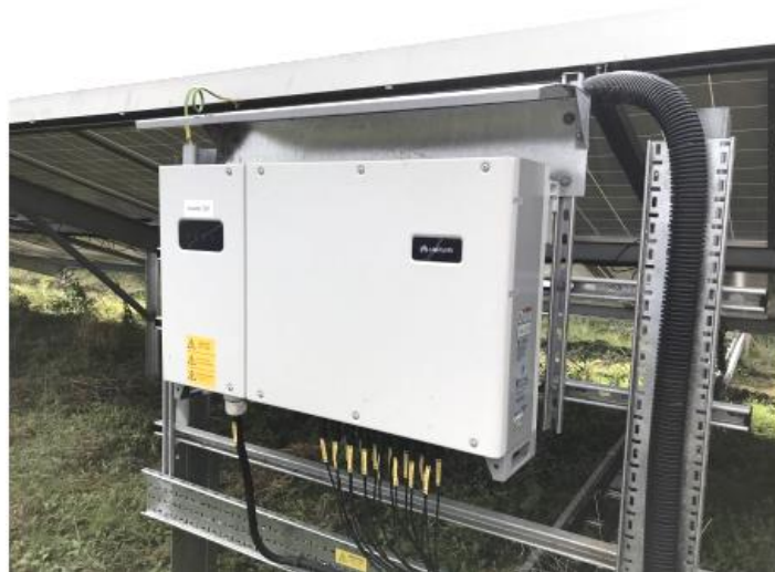
Slika 2. Detalj montaže izmjenjivača na konstrukciju
